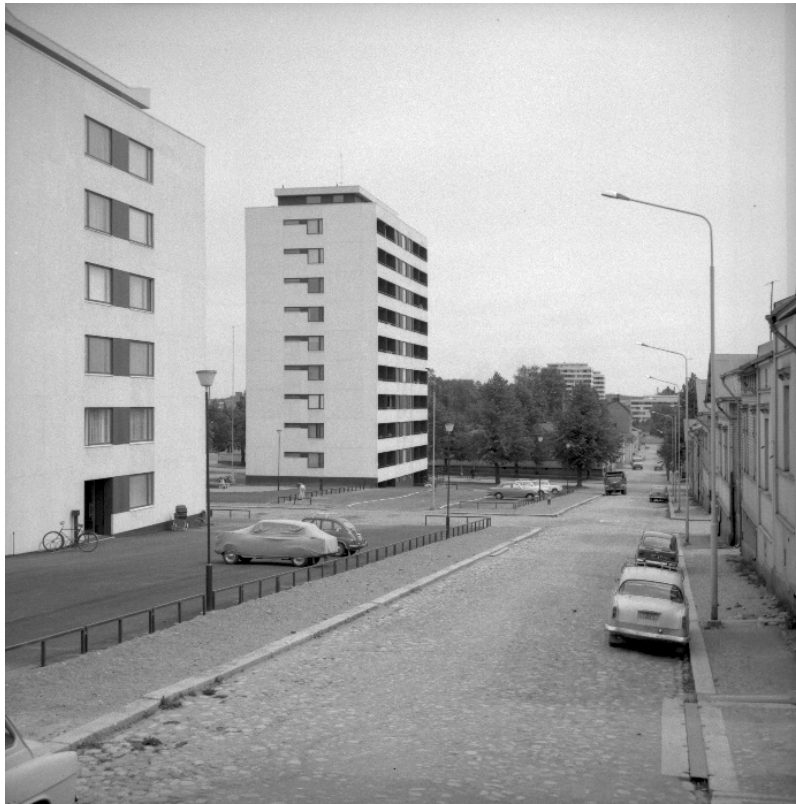
Kankurinkadun varteen rakennettiin arkkitehti Taito Uusitalon suunnittelema ja Tampereen Asuntosäästäjät ry:n Finlaysonin tehtaan työväelle rakennuttama kolmen kerrostalon kokonaisuus 1960-luvun lopussa. Rakennukset ovat hillittyä ja linjakasta modernia arkkitehtuuria. Kuva: Vapriikin kuva-arkisto, kuvaaja ei tiedossa.
