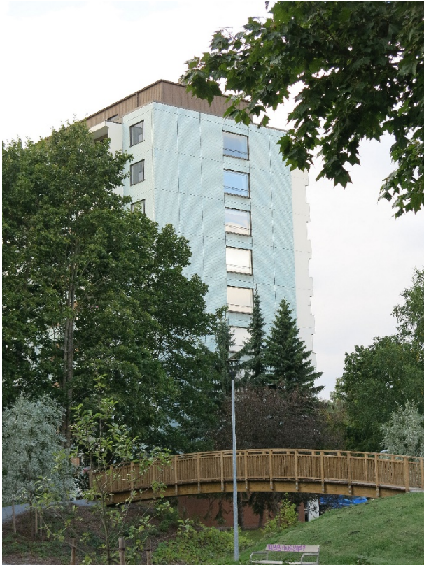
Pohjanmaan radan varteen sijoitettiin kuuden tornitalon rivi. Klinkkeripintaisen 1970-luvun alussa valmistuneen As. Oy Näsiniemen alkuperäiset piirteet on säilytetty. Kuva: Hannele Kuitunen 2015.
