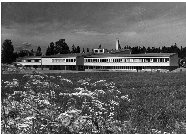
Kirkonkylän-Hyrylän kansakoulun pelkistetty hahmo tuusulalaisessa maaseutumaisemassa. Koulutilojen ohella rakennuksessa oli kunnan kirjasto, ja juhla-voimistelusalua sekä siihen hallin välityksellä liittyvää ruokasalia voitiin käyttää ”paikkakunnan yleisenä juhlahuoneistona”. Kuva: Heikki Havas / Arkkitehtuurimuseo.
