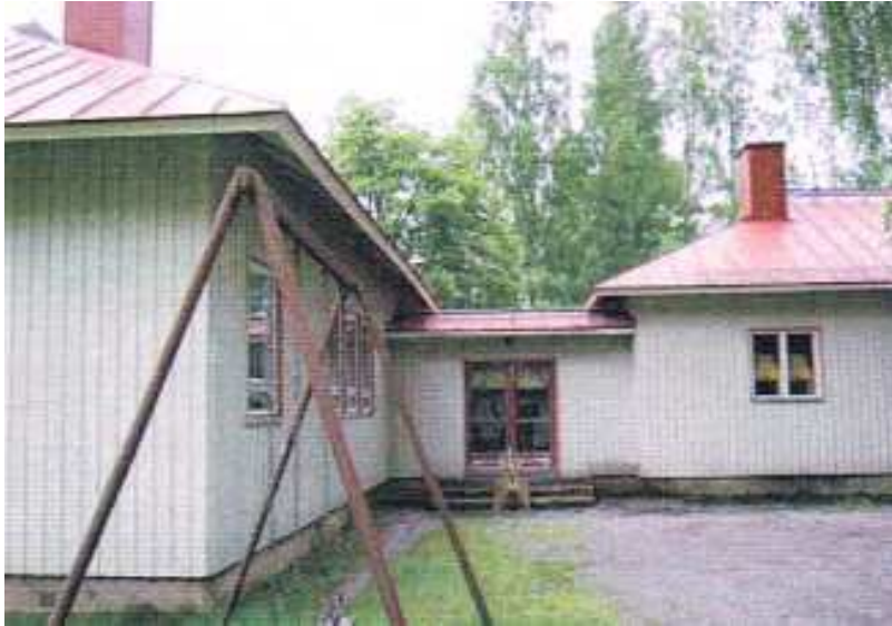
Kuva: Nastolan Uusikylän terveystalo on ilmeisen harvalukuisesti jääneen A-tyy- pin puinen terveystalo. Rakennus valmistui vuonna 1949. / Teija Ahola, 2003.
