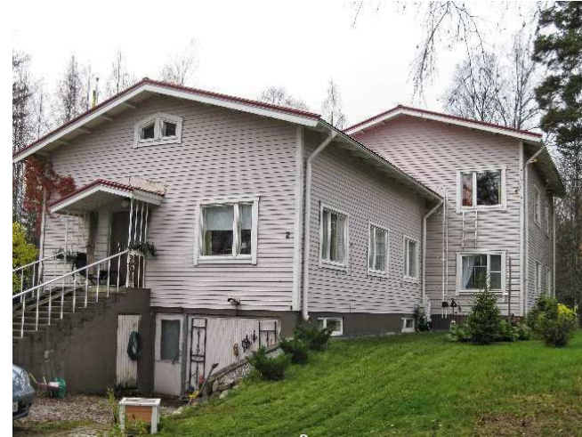
Kuva: Vuonna 1955 rakennettu Uuraisten kunnanlääkärintalo, suunnittelijana insinööri Tapio Vuorinen. Autotalli on kellarikerroksessa. Yksityiskäytössä. / Nina Moilanen 2012, Keski-Suomen museo.
