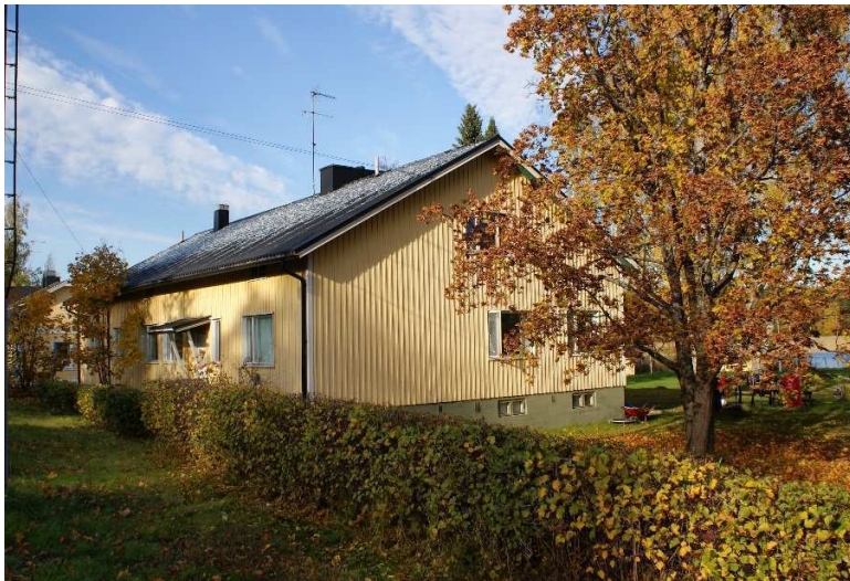
Kuva: Sulkavan kunnanlääkärintalo vuodelta 1955 on rakenteeltaan ja muodoltaan tyypillinen sotien jälkeisellä vuosikymmenellä rakennettu puutalo. Talossa on rankorakenne, rimalaudoitus ja betoniperustus. Sisäänkäyntien sadekatokset tai avokuistien katot ovat pulpettikattoja. Yksityiskäytössä. / Teija Ahola, 2010.
