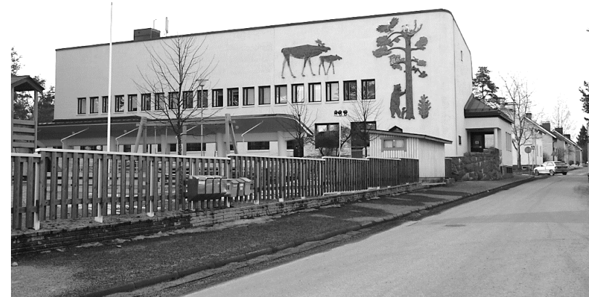
Kuva: Mikkelin Boråsin talo. Kaupunginarkkitehti Eero Jokilehdon suunnittelemaan lastentaloon tuli tilat lastenseimeä, lastentarhaa, neuvolaa ja henkilökuntaa varten. Lastentalon seinässä on vuonna 1950 valmistunut reliefi nimeltä "Nuori polvi" (Michael Schilkin). / Teija Ahola, 2014.
