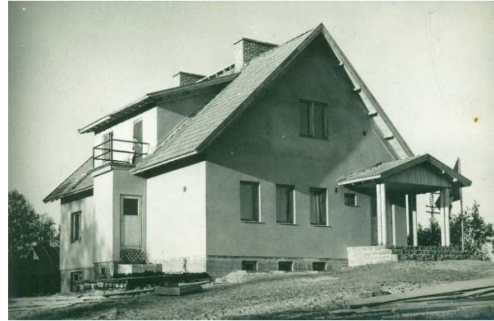
Kuva: Rapattu TT3 terveystalo on lokakuussa 1947 paranneltua mallia, jossa päädyn ikkunat muodostavat ryhmän ja asuntopuolen kuistin yläpuolelle on tehty pieni parveke. / Mikkelin mlk, Otava, MLL:n kuva-arkisto.
