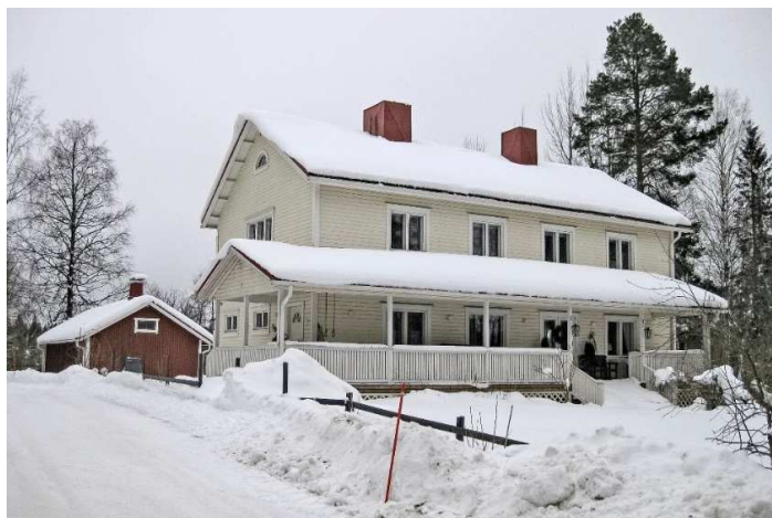
Kuva: Uuraisten terveystalo on tehty TT3-tyypin piirustuksilla, mutta yläkerran osalta laajennettu kattomuotoa muuttamalla. Nykyinen pitkä avoveranta lieenee myöhemmin tehty (muutosten ajoitus on joiltain osin epätarkka). Yksityiskäytössä. / Nina Äijälä 2012, Keski-Suomen museo.
