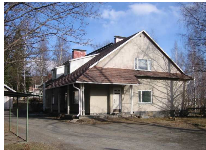
Kuva: Arkkitehtitoimisto Linnasalmen piirtämä Kalvolan kunnanlääkärintalo vuodelta 1948 muistuttaa Erkki Linnasalmen laatimaa TT3-tyypin terveystaloa. Talon katto on betonitiilestä, seinät rapatut ja sokkeli verhoiltu liuskekin. Erikoisuutena on nurkan kiertävä avokatos. / Teija Ahola, 2003.
