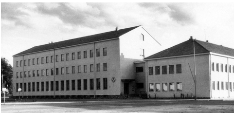
Pieksämäen 1955 valmistunut valtion virastotalo on arkkitehtuuriltaan tyypillinen Rakennushallituksessa 1950-luvulla suunniteltu virastotalo. Kuva: Rakennushallitus Uc:487, Kansallisarkisto.
