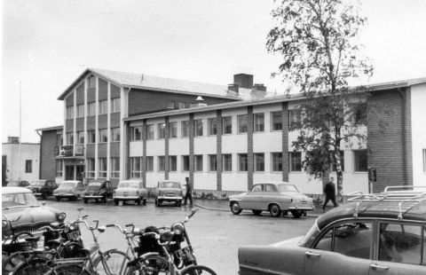
Imatralle valmistui 1960 suurehko ja ulkoasultaan omaperäinen virastotalo. Arkkitehti Aarno Raveala työskenteli 1954 lähtien Uudenmaanläänin lääninrakennustoimistossa.
