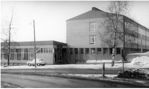
Karhulan virastotalo valmistui 1957 silloiselle Kymen läänin alueelle (Arkkitehtitoimisto Kokko & Kokko). Postin asiakastilat sijoitettiin matalaan siipirakennukseen.
