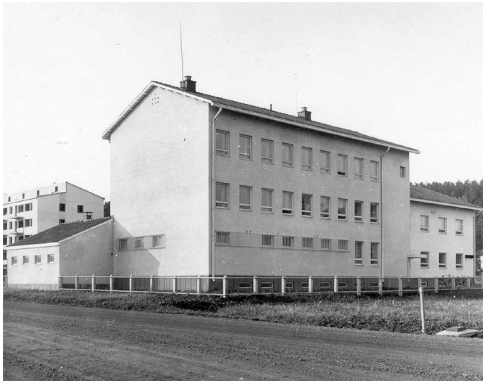
Kuusankosken virastotaloa suunniteltiin Rakennushallituksessa 1953 poliisi- ja verotalona. Se valmistui 1955 ja silloin sitä kutsuttiin valtion virastotaloksi. Kuva: Rakennushallitus Uc:123, Kansallisarkisto.
